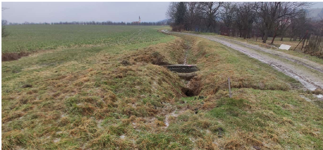
Pohled na stávající vtokový objekt a příkop zaústěný do vtokového objektu
